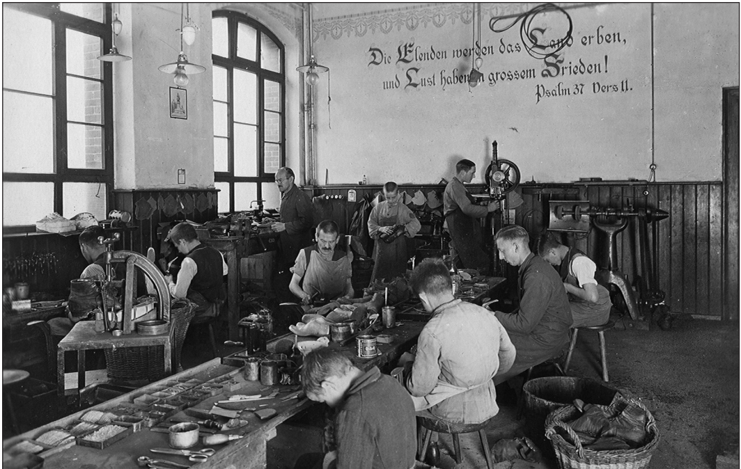
In der Schuhmacherei im Werkstättenhaus, 1920er Jahre. Die Leisten auf den Tischen sind ein Beleg dafür, dass hier eine regelrechte Handwerkslehre stattfand. Die Werkstatt ist mit elektrischem Licht ausgeleuchtet, von der Lichtleitung wird der Strom zum Antrieb der Maschinen abgezweigt. Der Wandspruch lautet: „Die Elenden werden das Land erben, und Lust haben in grossem Frieden!“ (Psalm 37,11).
